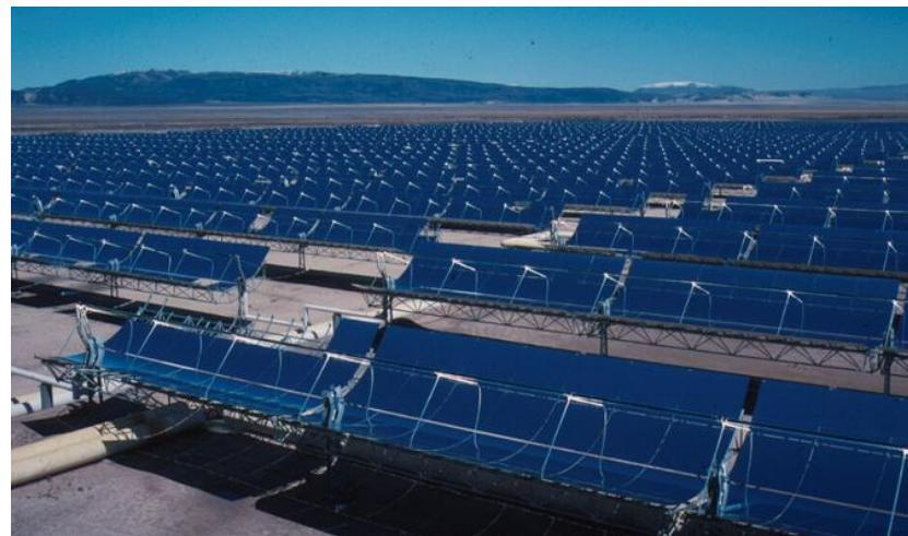
*Slika 6. : Dio parabolične protočne STE u SAD-u snage 354 MW*
