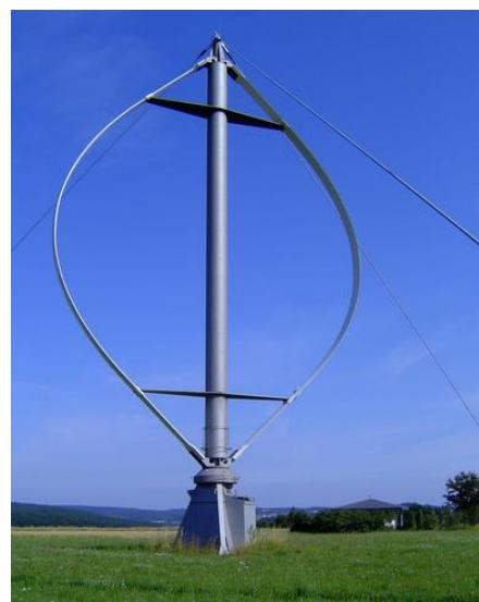
*Slika 11. : Primjer VE s vertikalnom osovinom*
