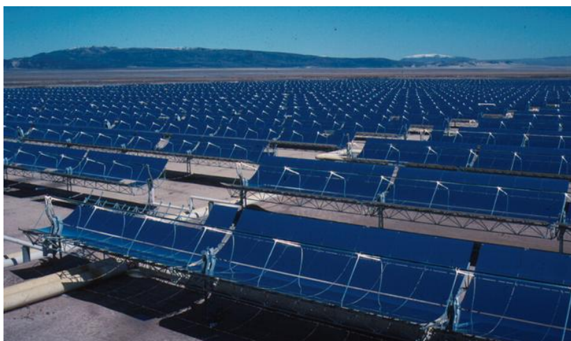
Slika 6. : Dio parabolične protočne STE u SAD-u snage 354 MW
