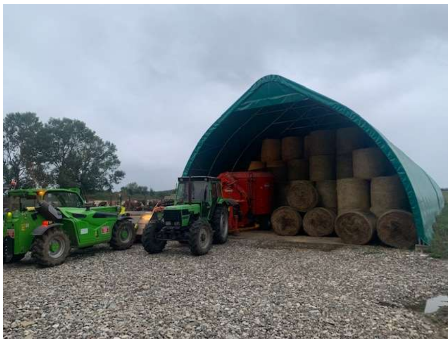
Slika 4. Tunel za sijeno
