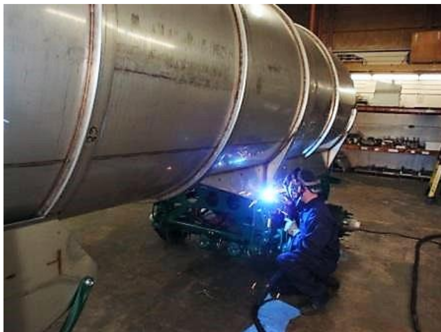
Slika 29. Popravak nehrđajućeg spremnika za gnojovku (Izvor: http://cdn2.hubspot.net/hub/61812/file-26198571-jpg/images/lynden_tank_employee_welding_tank.jpg )
