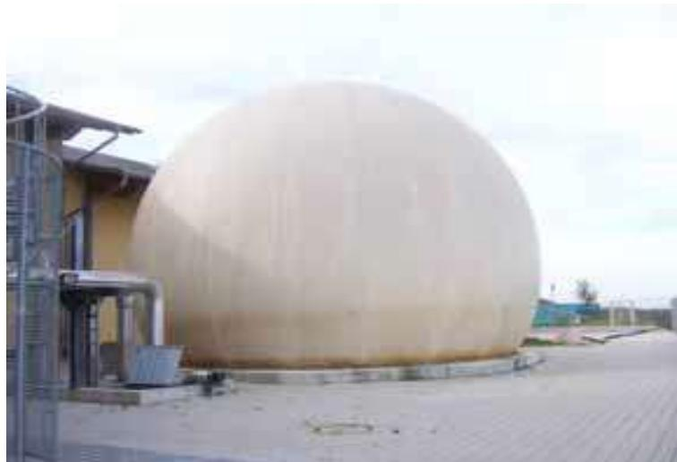
**Slika 2. izgled niskotlačnog spremnika** (Foto:Ruitz, 2007.)
