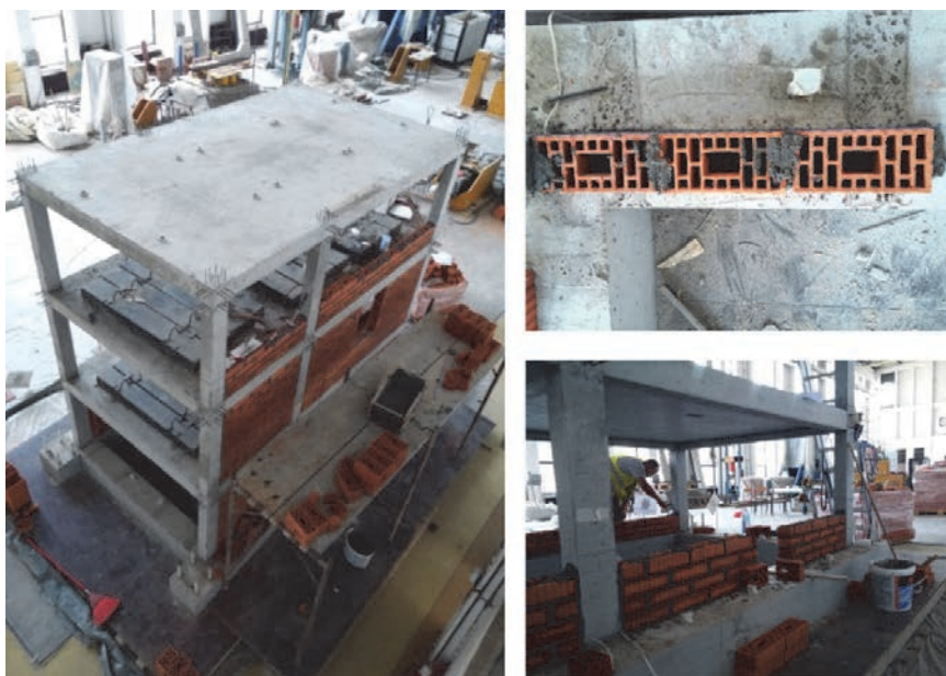
Slika 1. Izvedba šupljeg opečnog ispunskog zida [4]
