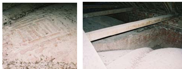
Slika 16. Ekstrados i oslonac svodene konstrukcije
