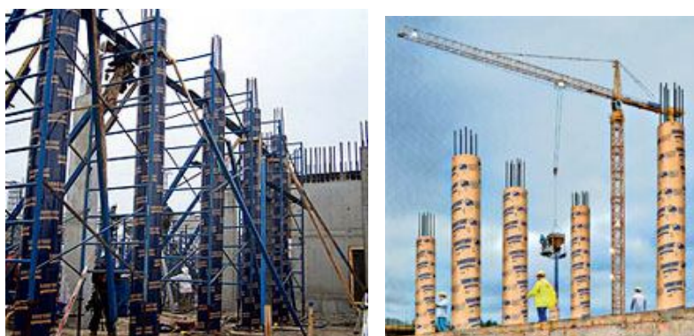
Slika 4 – Primjer korištenja recikliranog kartona u obliku oplata [11]
