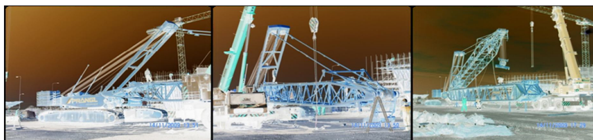
Slika 10 – Demontaža dizalice
