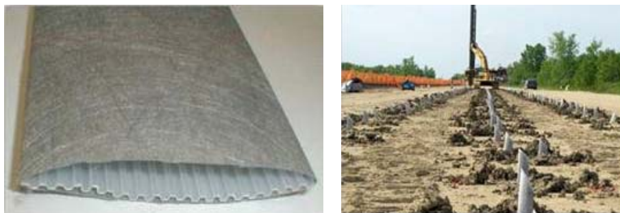
Slika 5 - Predgotovljeni vertikalni dren -PVD (lijevo) i postavljanje na terenu utiskivanjem specijalnim strojem i priborom (desno) [2]
