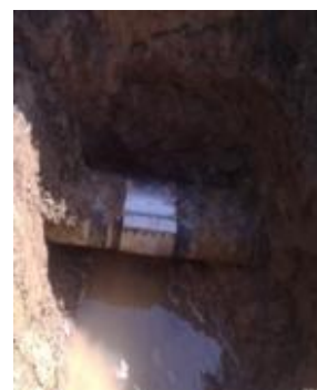
Slika 7. Lom PEHD cijevi na magistralnom cjevovodu te sanacija loma reparaturnom ogrlicom (rujan 2017.) Bizovačka bb. Valpovo
