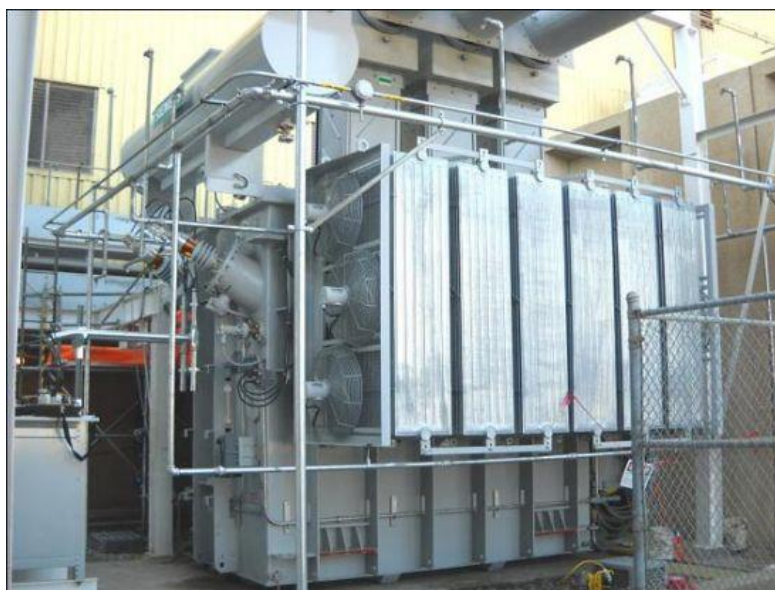
Slika 3.8. Trofazni transformator sa snagom 100 MVA
