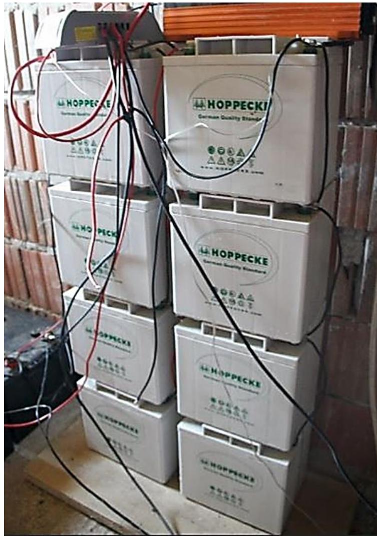
**Sl. 3.3.** Solarne baterije spojene serijski i paralelno.
