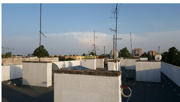
Slika 4.7. Ravni krov zgrade.
