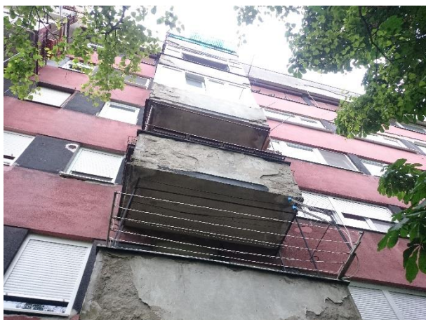
Slika 4.25. Oštećenja balkona.
