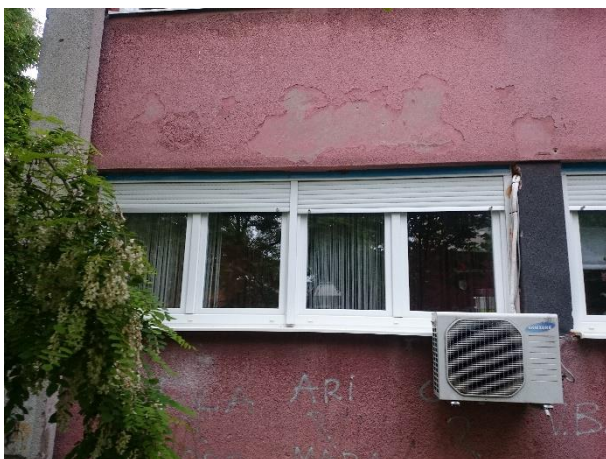
Slika 4.17. Karakteristični otvor zgrade PVC-IZO (prozor stambenog prostora).
