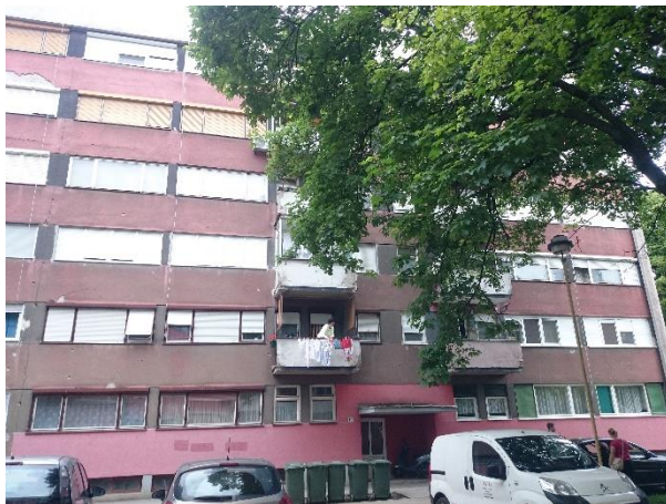
Slika 4.3. Istočno pročelje zgrade.
