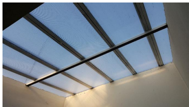
Slika 4.16. Karakteristični otvor zgrade M-JED (svjetlarnik stubišta).
