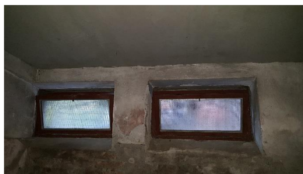
Slika 4.12. Karakteristični otvor zgrade M-JED (prozor podruma).
