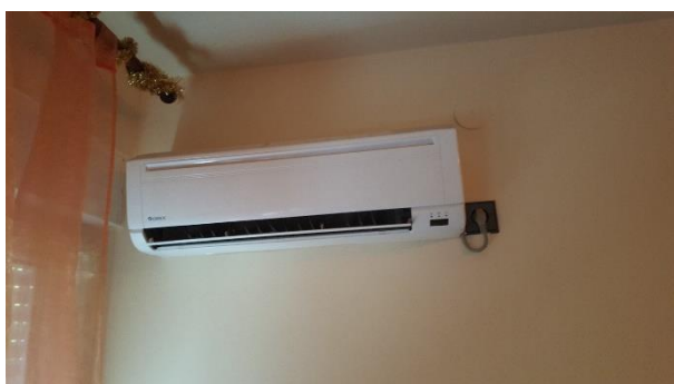
Slika 4.33. Jedan od split klima uređaja (unutarnja jedinica).
