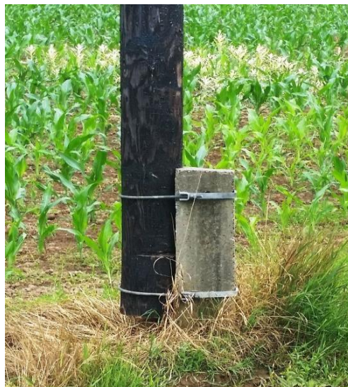
Sl. 3.12. Betonske nogare kod drvenih stupova
