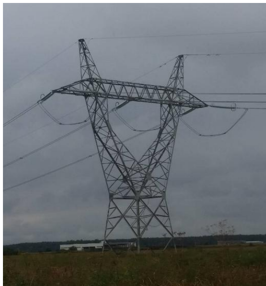
Sl.2.8. Jednostruko čelično-rešetkasti stup " Y-stup"
