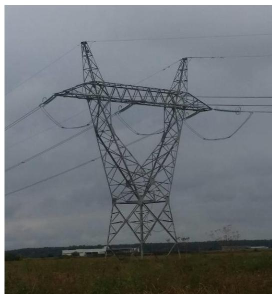
**Sl.2.8.** Jednostruko čelično-rešetkasti stup " Y-stup"
