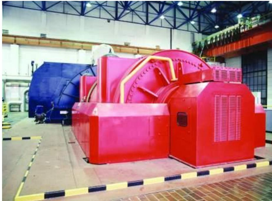
Slika 2.1. Turbogenerator termoelektrane Plomin u Hrvatskoj, 1x247 MVA [3]
