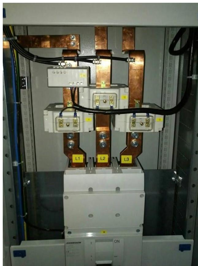
Slika 3.2. Mjerni transformatori (strujni) u električnom ormaru - Nova Gradiška, 2017.
