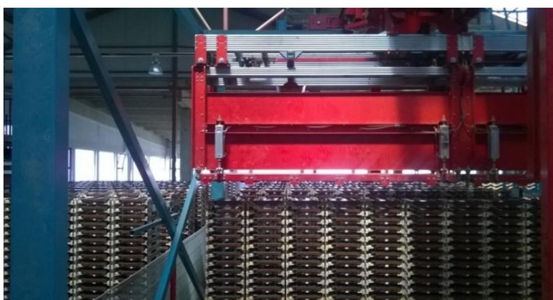
Slika 4.34. Skidanje crijepa s vagona
