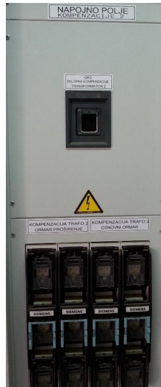
Slika 5.21. Napojno polje kompenzacije za transformator 2
