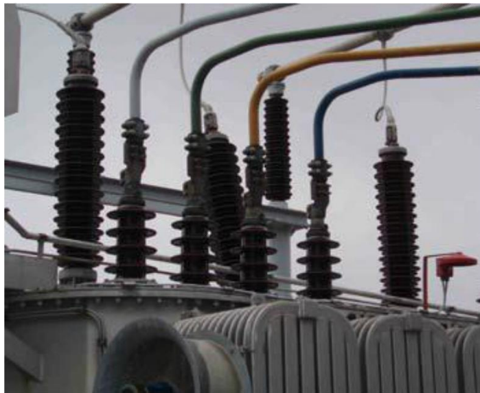
Slika 4.4.4. Termogram energetskog transformatora snimljen s stražnje strane [5]
