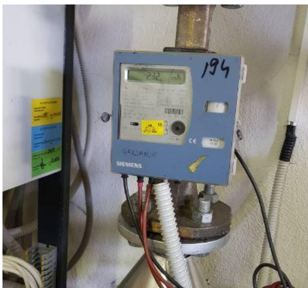
Slika 5.1. Kalorimetar Siemens RVD250.
