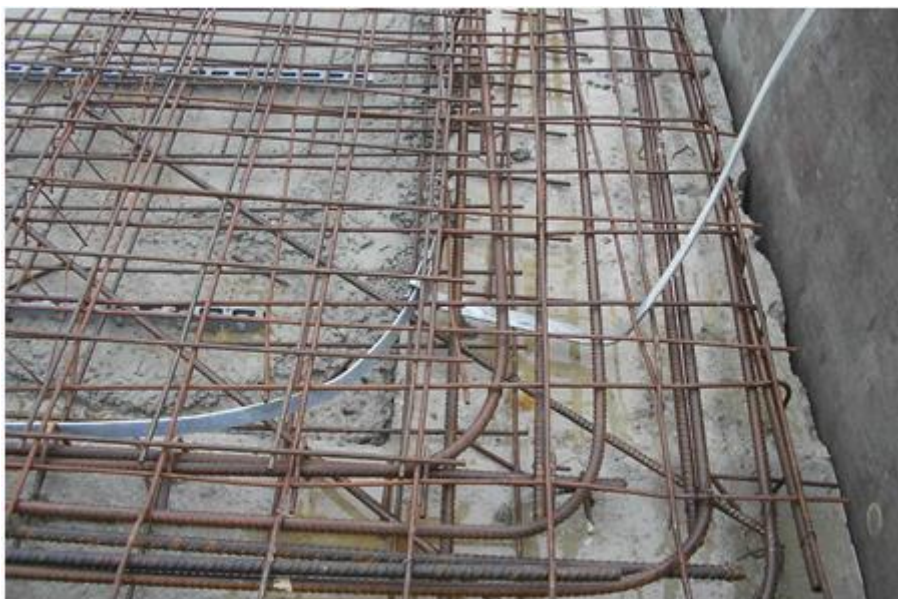
Slika 5.10 Temeljni uzemljivač [5]
