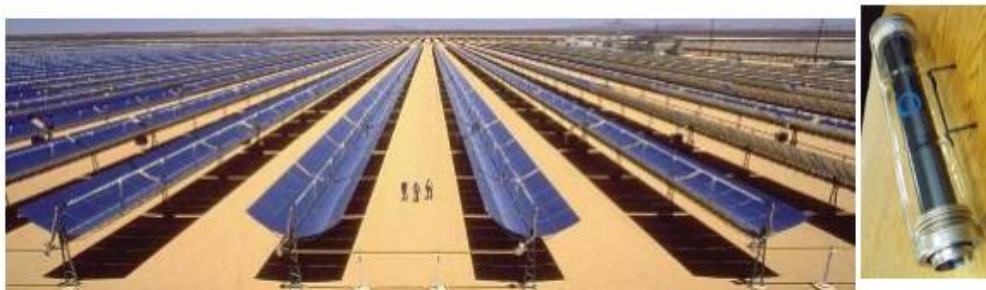
Slika 3.1. Izgled parabolične protočne solarne termoelektrane [4]
