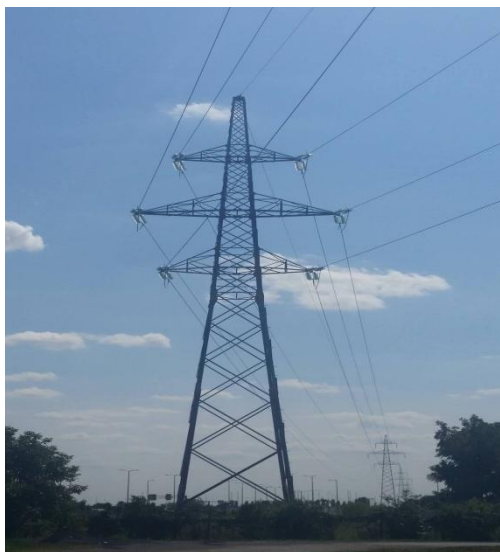
Sl.2.10. Dvostruko čelično-rešetkasti stup, oblik "bačva"
