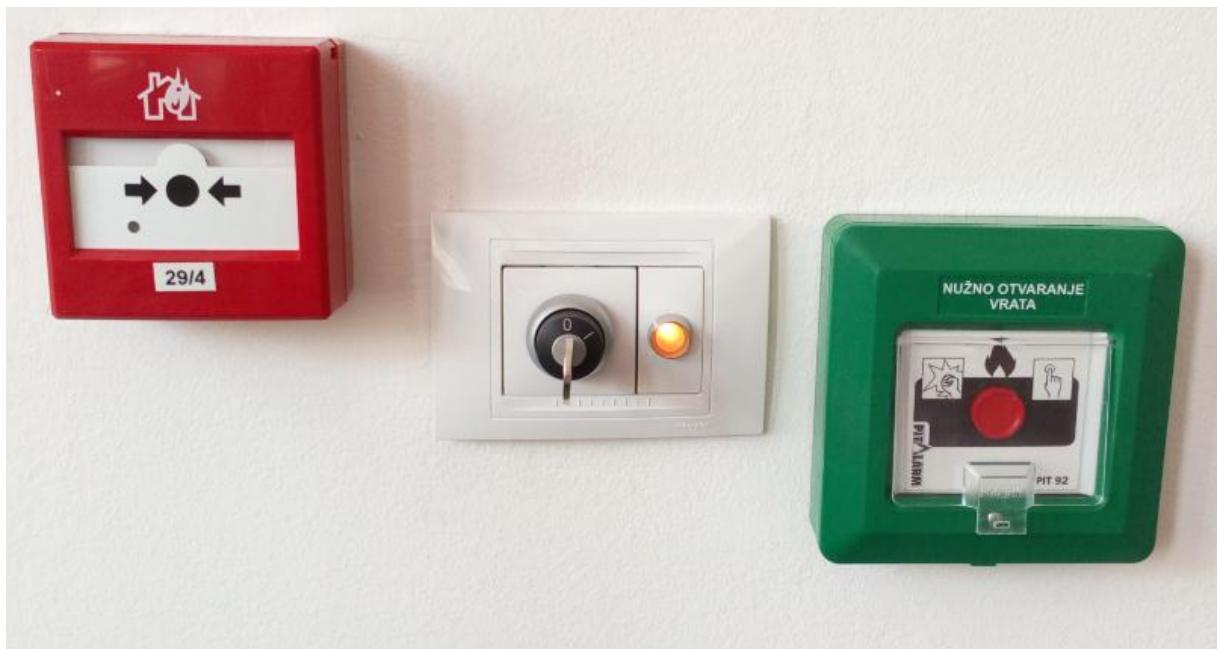
Sl. 5.3. IPR tipkala vatrodojave, nužnog otvaranje vrata i bravica sa ključem za servisno otvaranje vrata.
