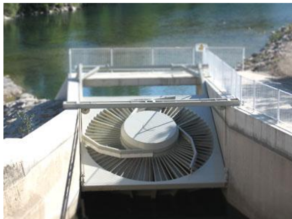
Slika 2.13. VLH turbina u povučenom položaju
