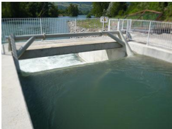
Slika 2.12. VLH turbina u radnom položaju
