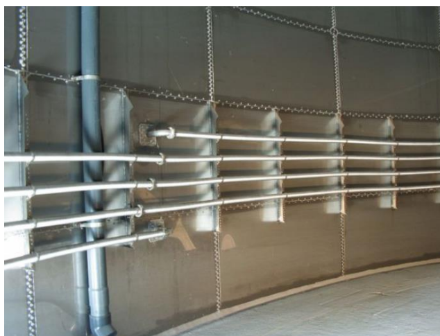
Slika 2.10. Cijevi za grijanje unutar fermentora [4]
