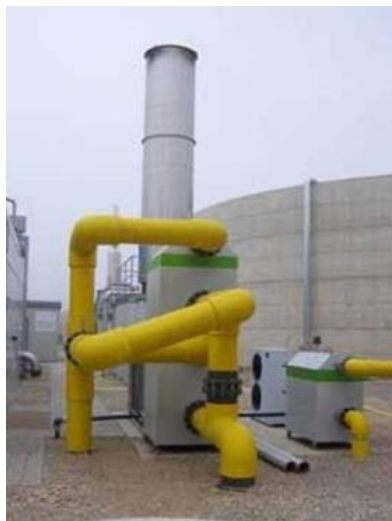
Slika 2.16. Izgled baklje za izgaranje bioplina [4]
