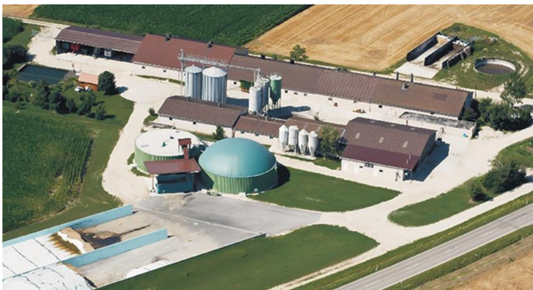
Slika 6. Bioplinsko postrojenje u Dvoru iz zraka
