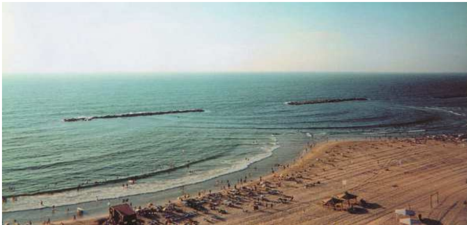
Slika 3. Na slici je prikazana interferencija valova na plaži u Tel Avivu, Izrael. Valovi prolaze kroz „pukotine“ u obalnom zidu i stvaraju nove valove koji oblikuju obalu. [9]
