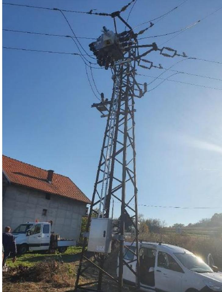
Slika 5-10 Konačan izgled cijelog stupa s DURN-om i upravljačkim ormarom
