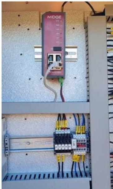
Slika 5-7 Primjer ugradnje GPRS-a u upravljački ormarić
