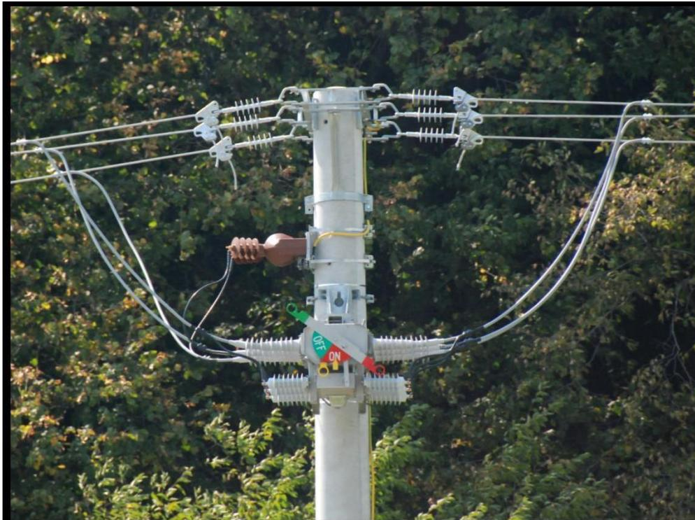
Slika 3-1 Prikaz rastavne sklopke RL-Serijsa montirane na stup
