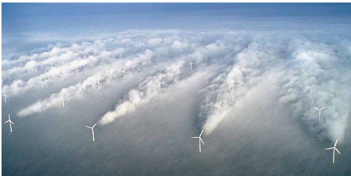
Slika 2.6 Efekt međusobnog zaklanjanja vjetroturbina u vjetroelektrani [6]
