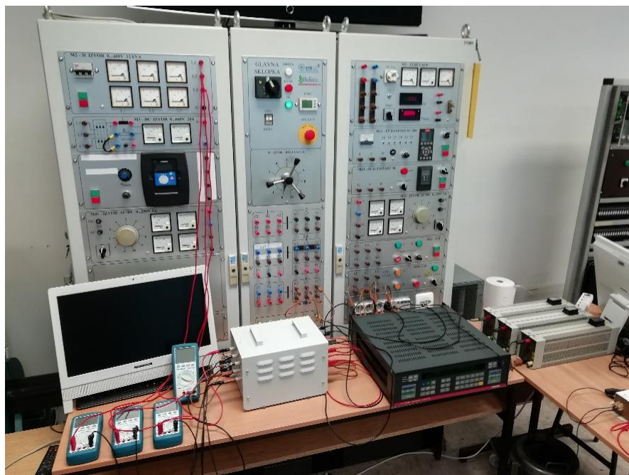
Sl. 3.21. Provedba mjerenja pri simetričnom opterećenju transformatora
