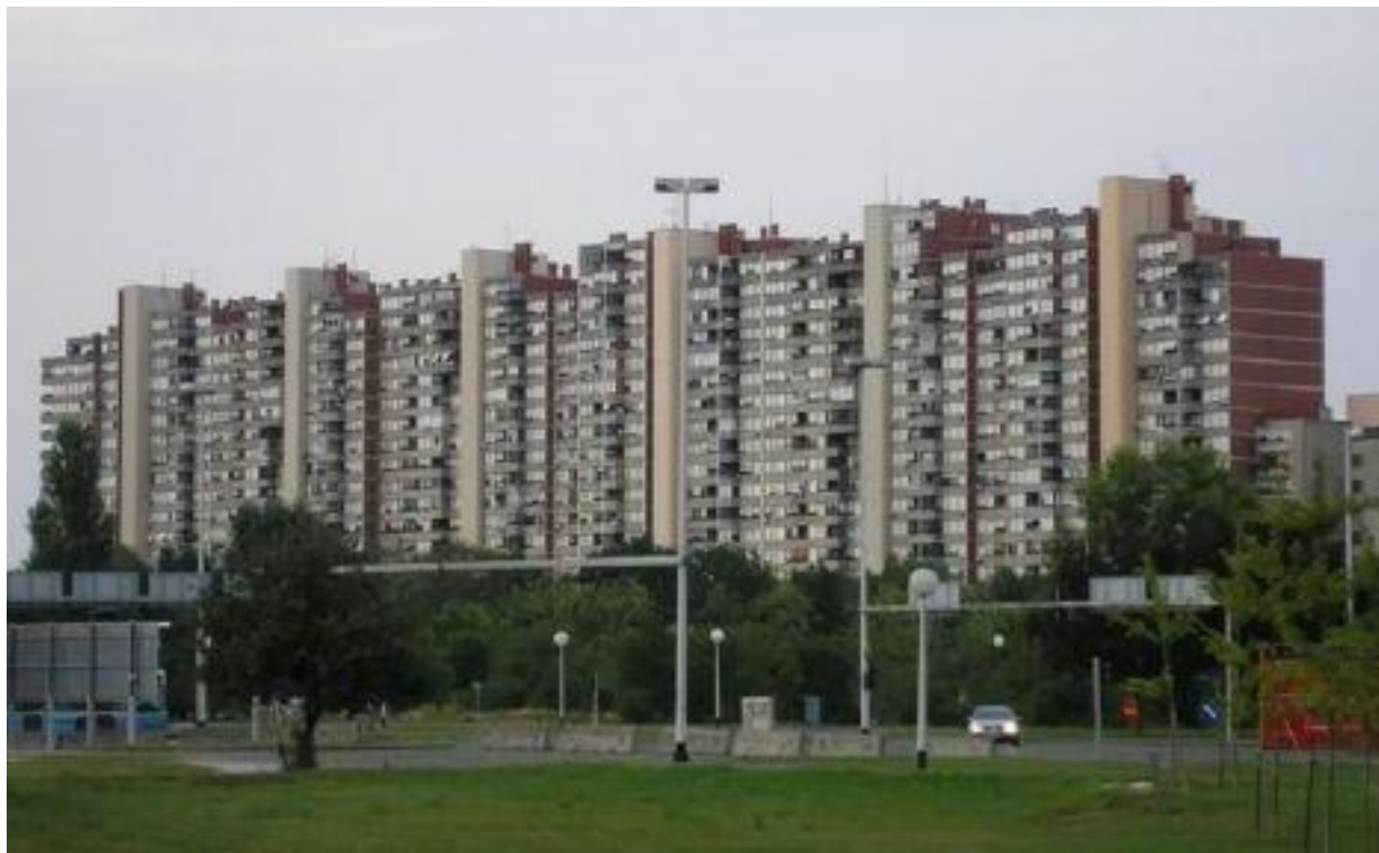
Slika 5.4 Zgrada Mamutica u Zagrebu [18]
