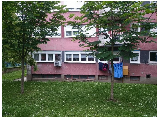
Slika 4.4. Zapadno pročelje zgrade.
