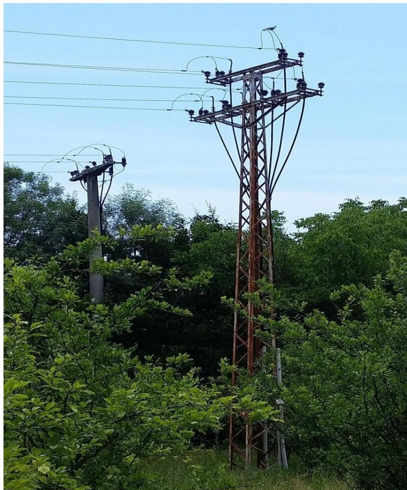
**Sl. 3.11.** Krajnji betonski i čelično rešetkasti 10 kV stupovi
