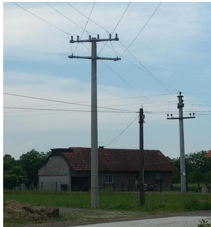
**Sl. 3.10.** Betonski odcjepni 10 kV stupovi s različitim oblicima glave stupa
