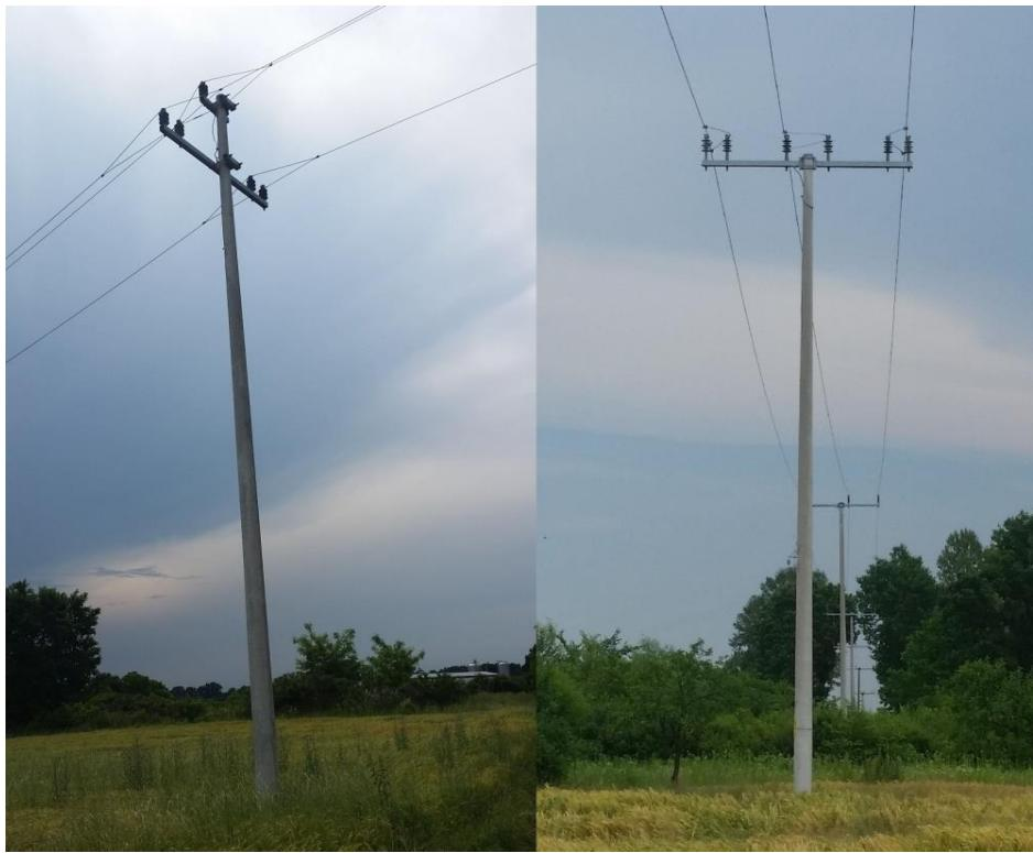
**Sl. 3.9.** Betonski nosivi linijski 10 kV stupovi s različitim oblicima glave stupa
