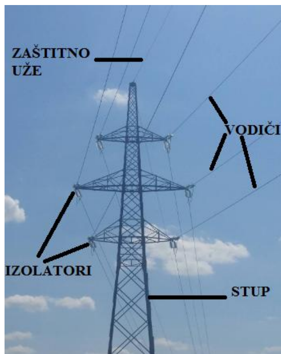
Sl.2.1. Nadzemni vod s osnovnim dijelovima
