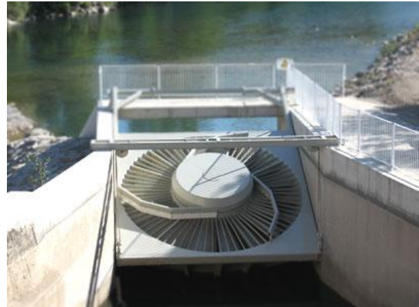
Slika 2.13. VLH turbina u povučenom položaju
