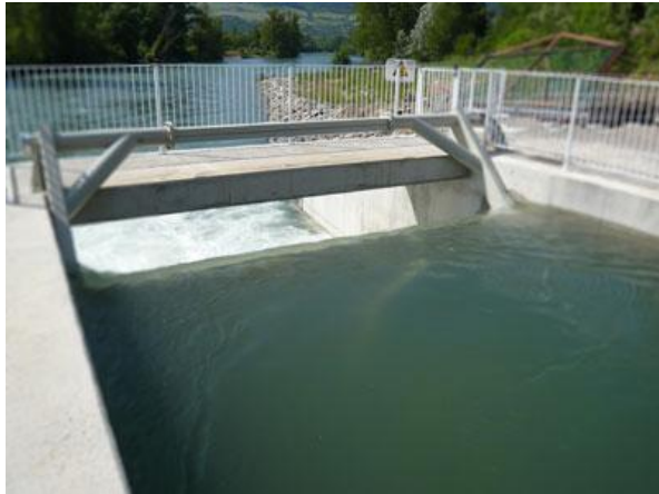
Slika 2.12. VLH turbina u radnom položaju
