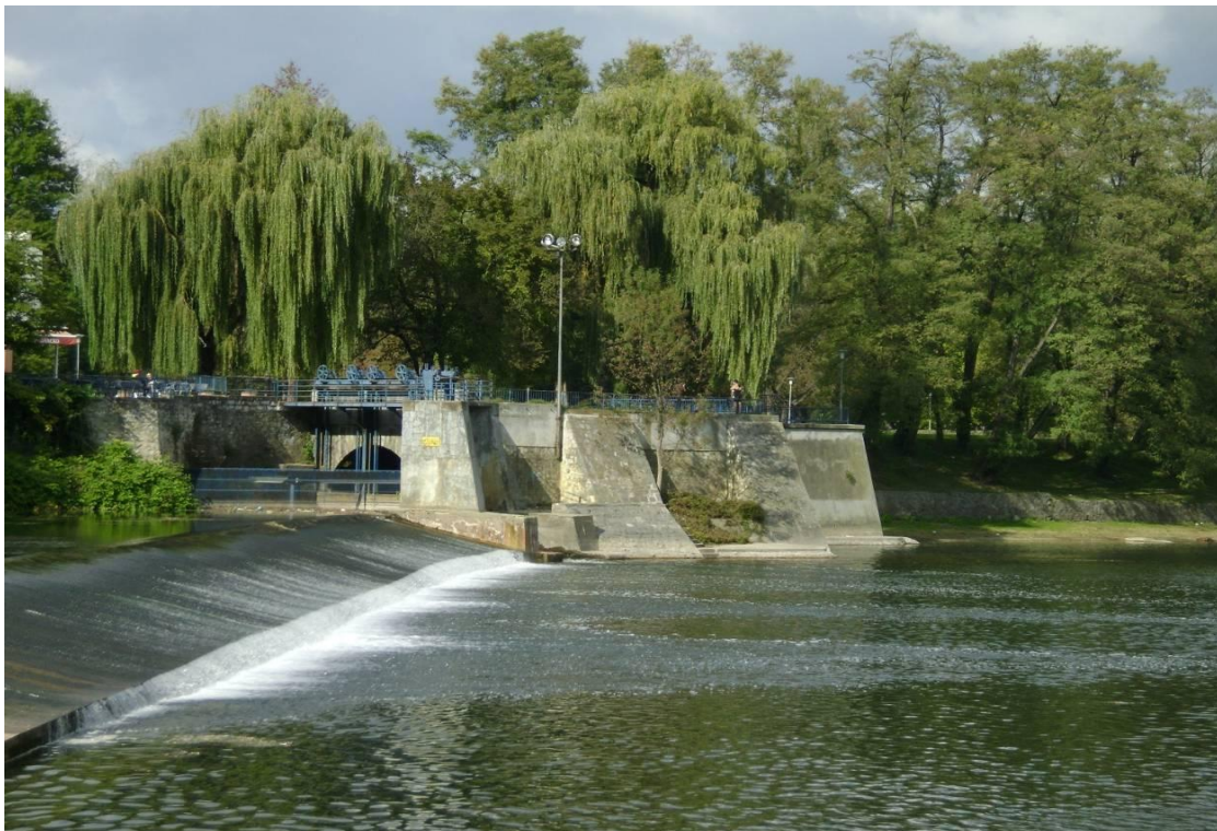
Slika 2.2. Izgled brane MHE Korana 1
