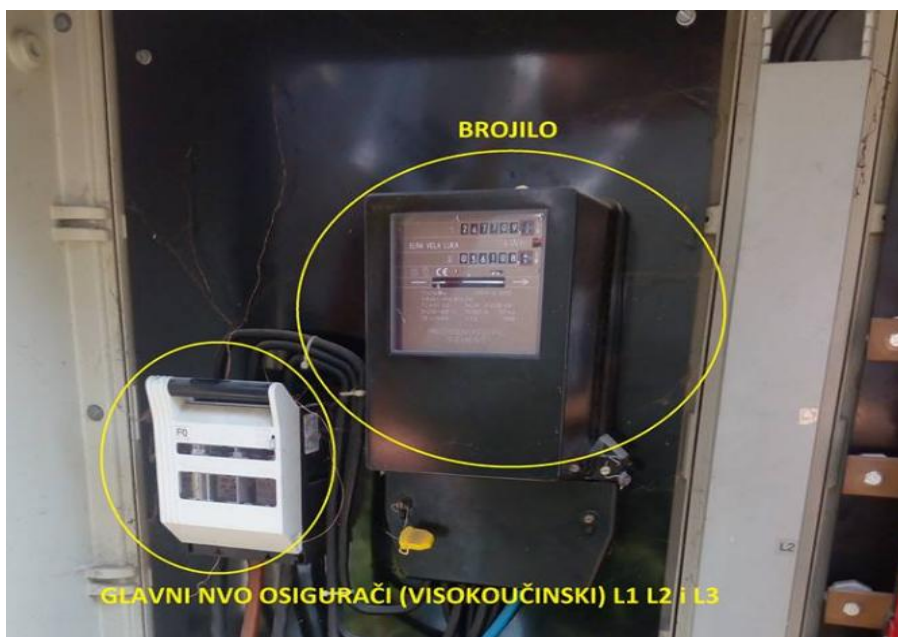
Slika 4.2.8. Sadržaj ormara javne rasvjete (OCR).
