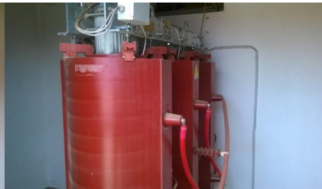
Slika 5.2. 10/0,4 kV transformator
