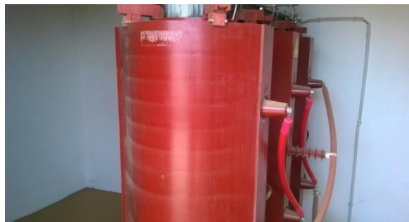
Slika 5.4. 10/0,4 kV transformator
