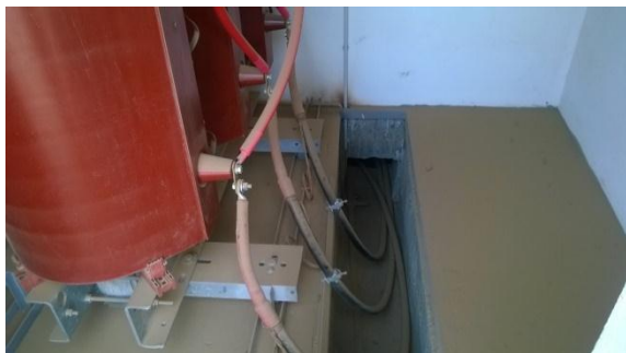
Slika 5.3. 10/0,4 kV transformator
