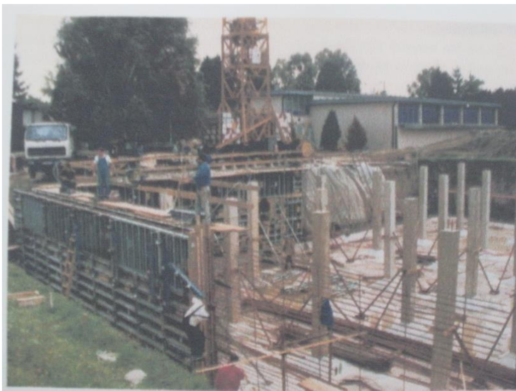
Slika 3.1. Vodosprema pitke vode 2500 m 3
